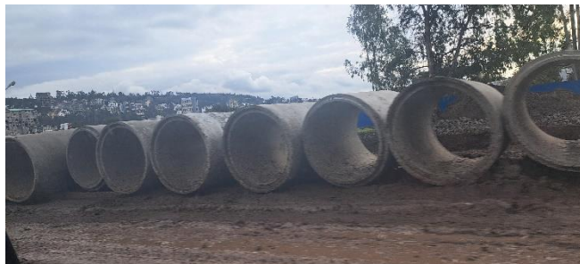
De werken willen ook de infrastructuur grondig moderniseren.
