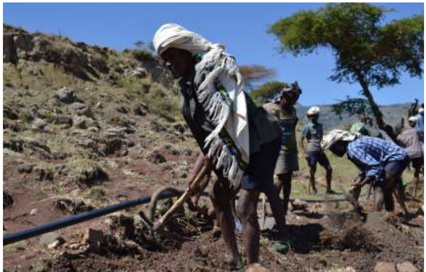
Boeren leveren de arbeid bij het graven van de sleuven voor de leidingen (2015 Debre Sina)
